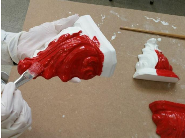
Foto 6, Aflak alkydhars kleur rood voor ondergrond van het bladgoud
