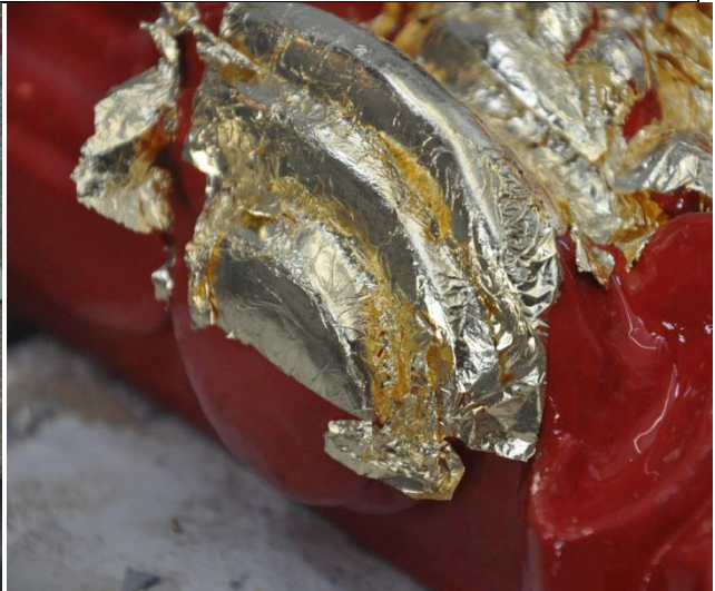
Foto 19, Leg het volgende blaadje op de ondergrond, iets over je al geplakte deel
