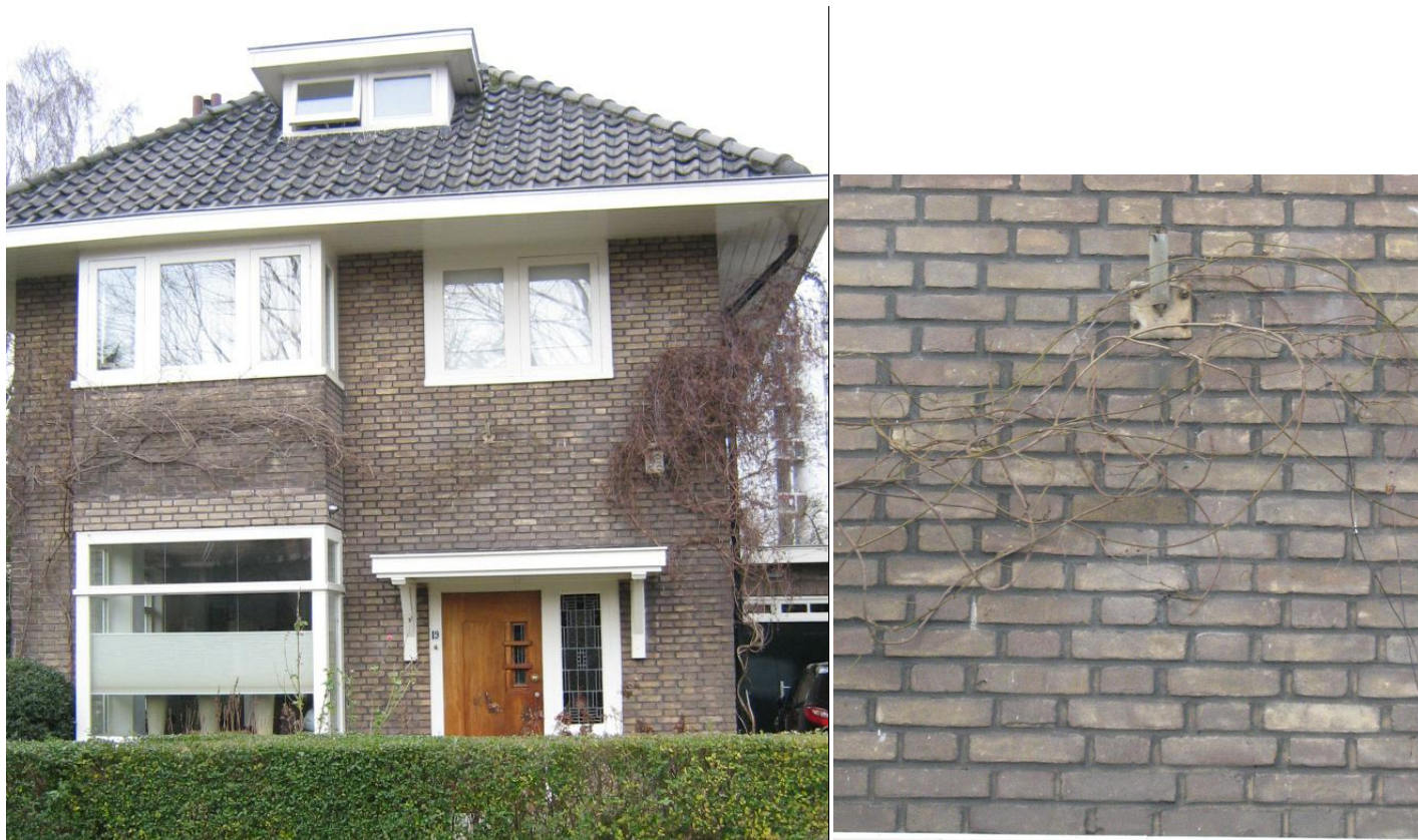
Vlaamsverband, waalformaat bruine baksteen Holle, donkergrijze voeg
