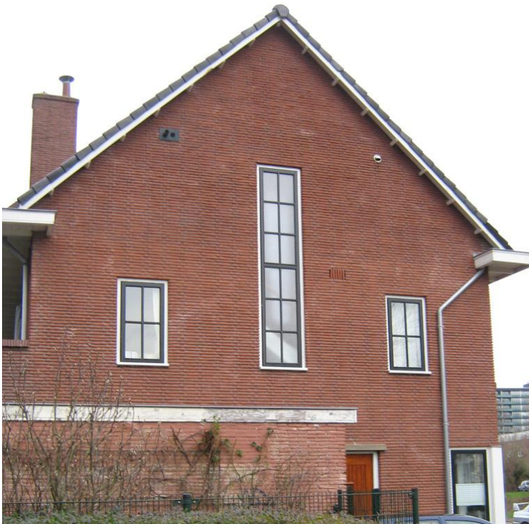
Kettingverband, Hilversumsformaat rode baksteen iets terug gehouden voeg, grijs
