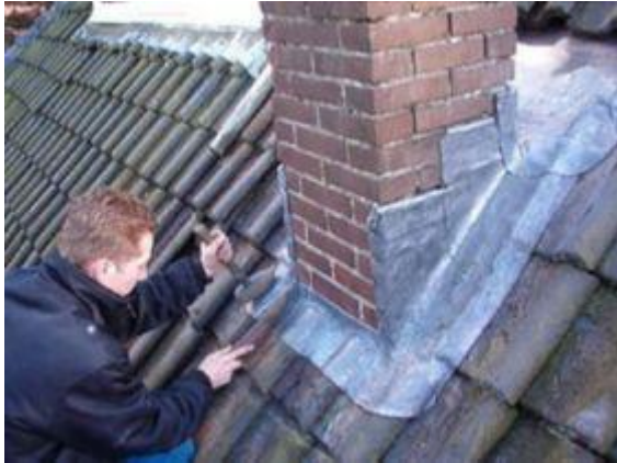
Figuur 19, Vervangen van lood op het dak
