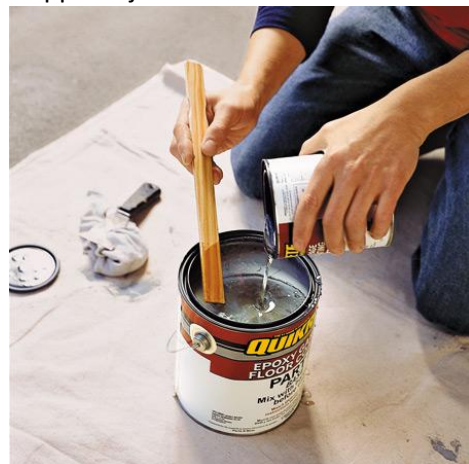
Figuur 13, mengen van een epoxy
