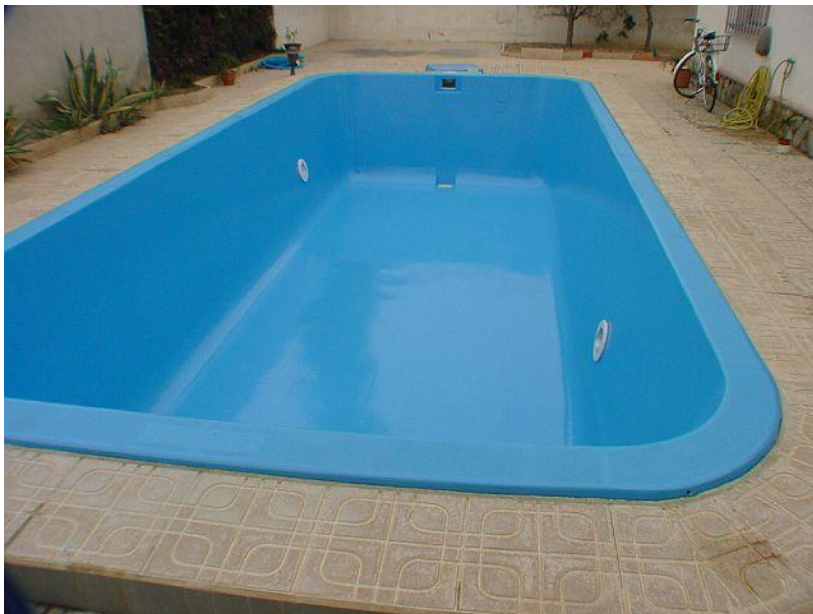
Fiuur 8,. Voorbeeld toepassing chloorrubberverf
