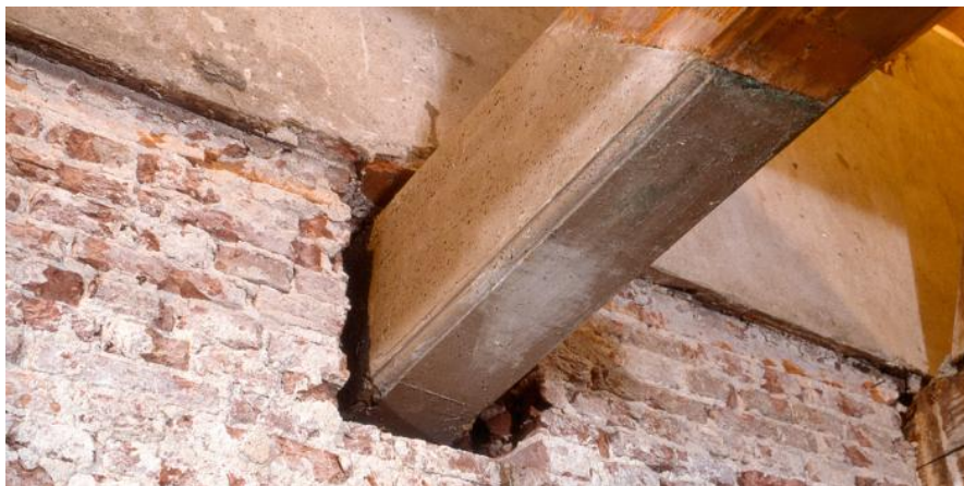
Figuur 75, Eindresultaat na verwijderen van de bekisting
