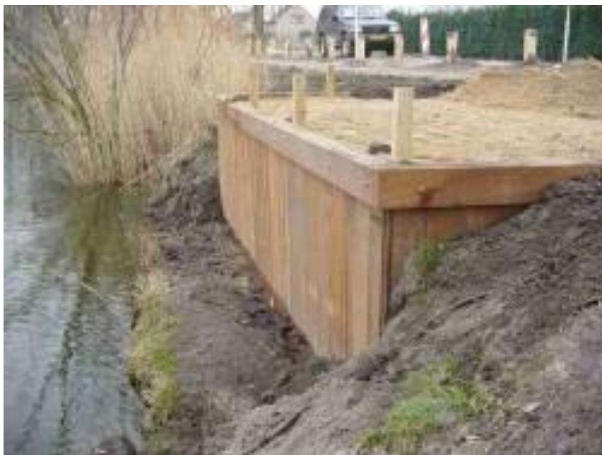
Figuur 53, Damwand van robinia
