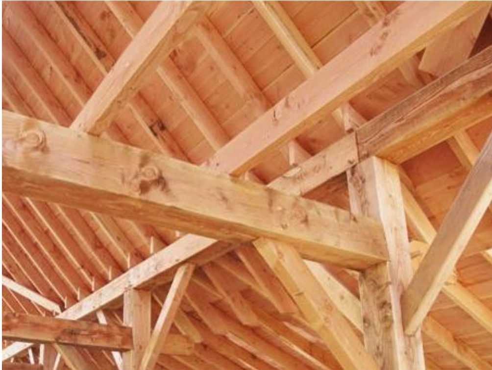
Figuur 50, Kapconstructie van Douglas
