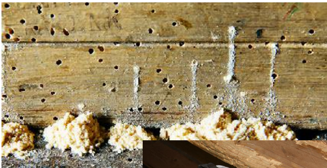
Figuur 55, Hout aantasting door insecten
