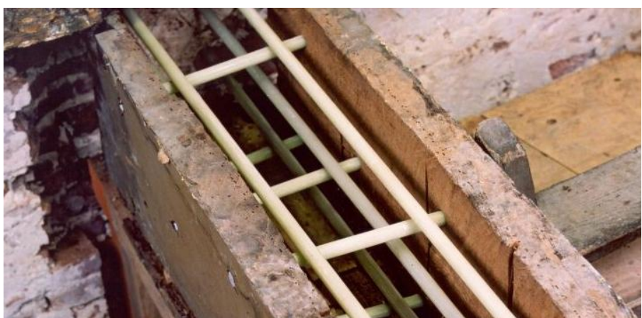
Figuur 74, De bekisting met glasvezelstaven voor het gieten van de epoxyhars
